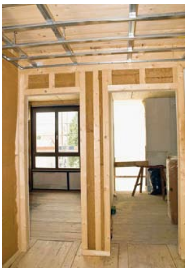
◀ Einseitig offene Innenwände mit Holzfaserdämmung: Die Unterkonstruktion wartet auf Zementfaserplatten
