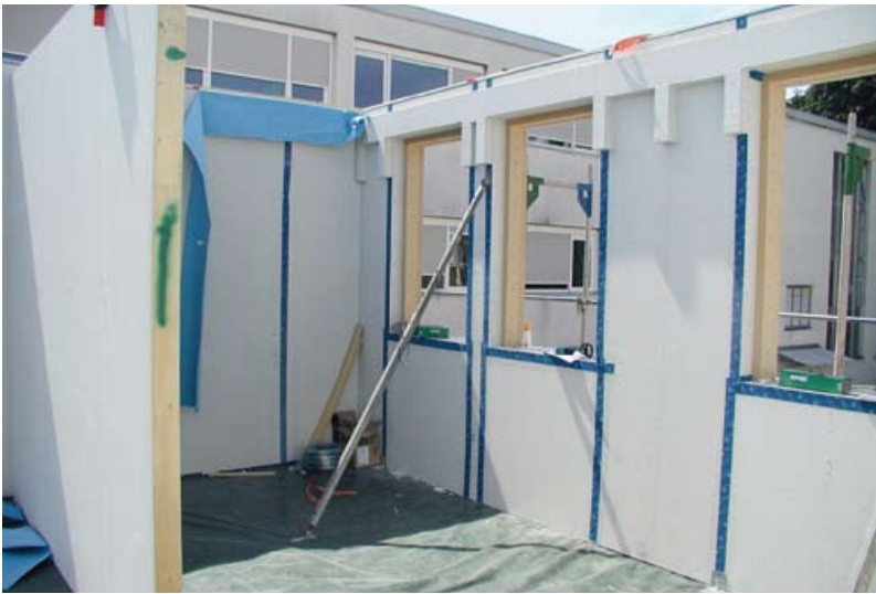
◀ Mit Zementfaserplatten beplankte Randbalken im Bereich der Wandkronen dienen an den Außenwänden als Auflagerkonsole für die Deckenelemente
